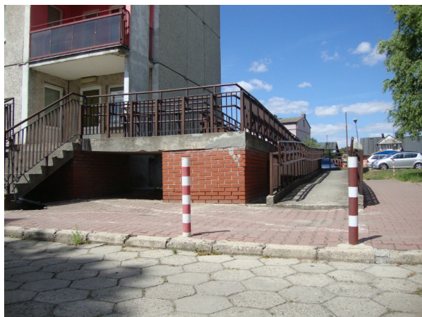
Fot. 1. Widok pochylni od strony południowej
